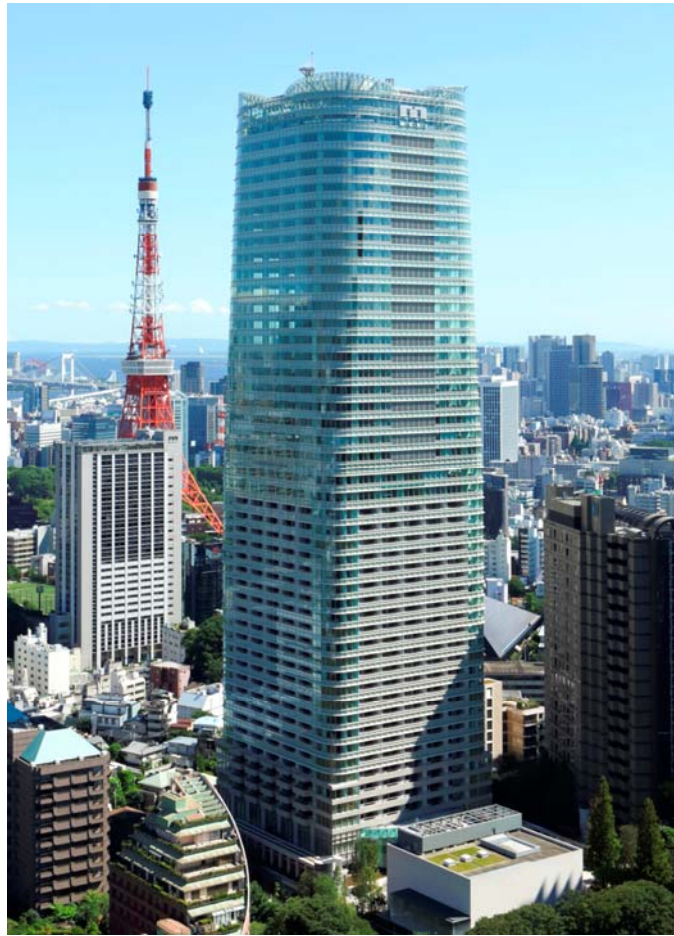
<参考資料1> アークヒルズ 仙石山森タワー 外観写真
